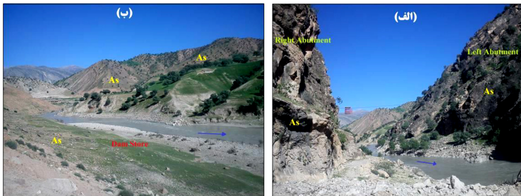
شکل ۶. رخنمون سازند آسماری (As) در (الف). تکیه‌گاه‌ها (دید به سمت شمال خاوری) و (ب) مخزن سد (دید به سمت خاور) (رحیمی شهید، ۱۳۹۴)
