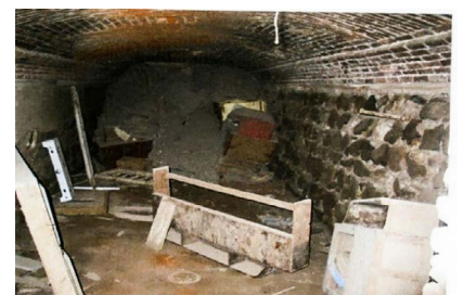
▲ شکل ۷. سنگ در دیوار چینی و سقف قوسی آجری در زیرزمین (نگارندگان، ۱۳۹۸).
