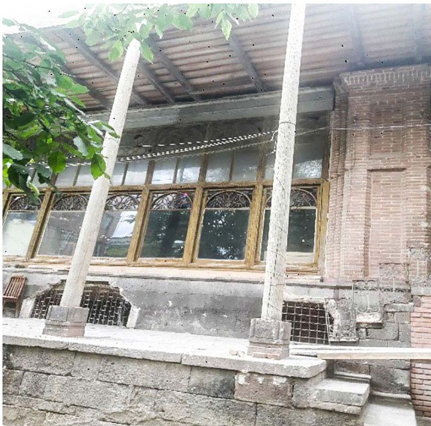
▲ شکل ۸. ستون‌های چوبی در بنای وکیل‌الرعیای (نگارندگان، ۱۳۹۸).
