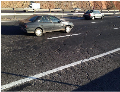
شکل ۱. تصاویری از مشکلات ناشی از خاک متورم شونده در بزرگراه شمالی تبریز
