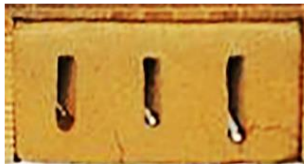
شکل (۱۵). تیرکشی‌های آجری نمای ورودی عمارت
