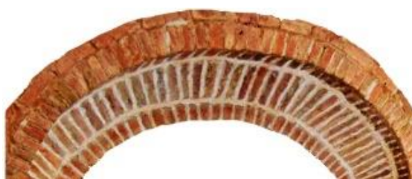
شکل (۱۴). قاب‌بندی آجری پنجره‌های نمای بیرونی و درونی عمارت
