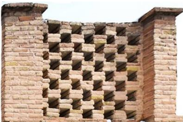
شکل (۱۱). آجرکاری فخرمدین نمای شمالی دیوار بیرونی عمارت
