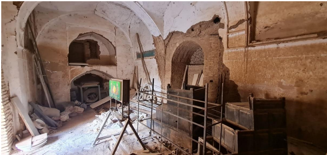
شکل (۱۰). وضعیت اتاق تدفین قبل از شروع گمانه‌زنی (دید به جنوب غربی) (دهقانی)
