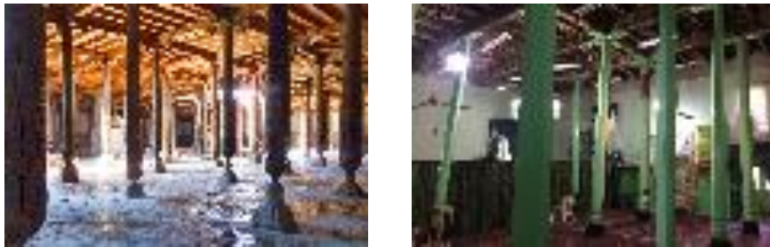
تصویر ۱۸: پا ستون، ستون، سرستون و تیرریزی در مسجد جامع ازغد (راست)، (نگارندگان، ۱۴۰۵) و مسجد جامع خیوه (چپ)، (بلالی اسکویی و آشتیانی، ۱۳۹۹). Fig. 18: Wooden Structural System of the Jameh Mosque of Azghad and the Jameh Mosque of Khiva (Belali Oskoui & Ashtiani, 2020).
