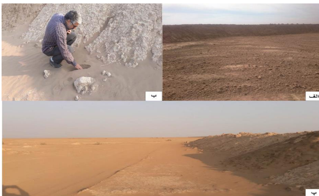
شکل ۱۱. الف) احداث بادشکن در یکی از کانون‌های ریزگرد استان خوزستان، ب و پ) ریزگرد مهار شده در پشت بادشکن الف بعد از حدود یک سال
