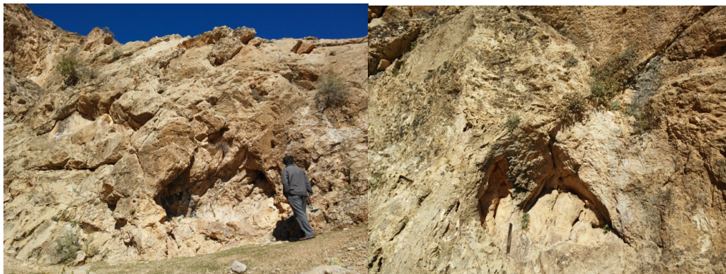
شکل ۱۴. ناپایداری‌های بلوکی به دلیل وجود سیستم درزه‌های متقاطع
